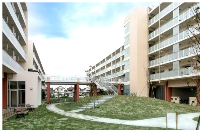
写真2：住棟をつなぐコミュニティデッキ（出典：UR都市機構）
